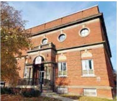
La première pierre du temple maçonnique de Moncton a été posée le 17 octobre 1923.
